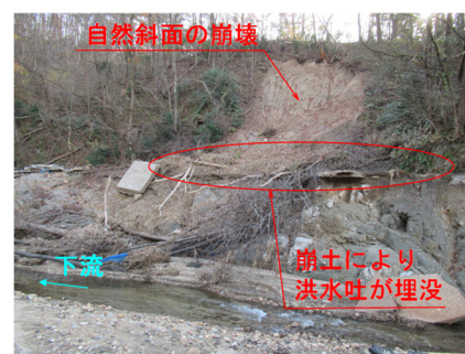
(b) 右岸側自然斜面の崩壊
